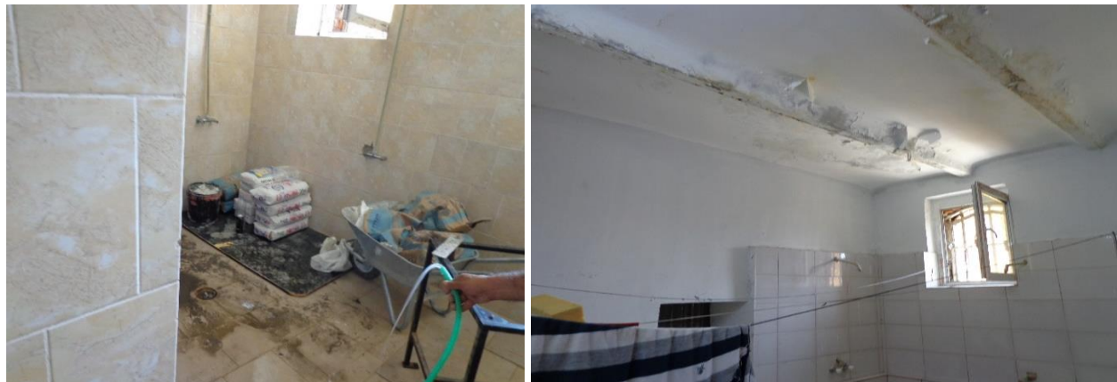
Помещения, в които се провеждат ремонтни дейности
